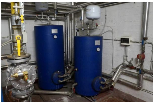
Figura 4.14 Particolare dei componenti dell'impianto solare termico in centrale termica
